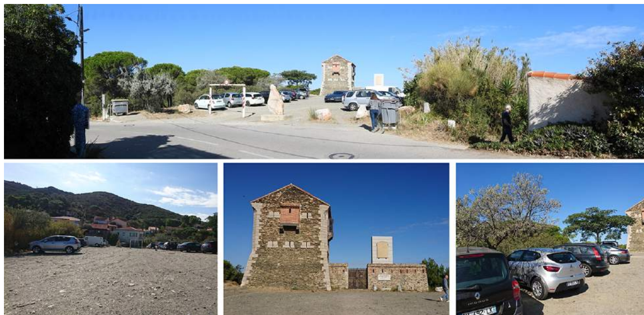
> Le site existant de la Redoute Béar
